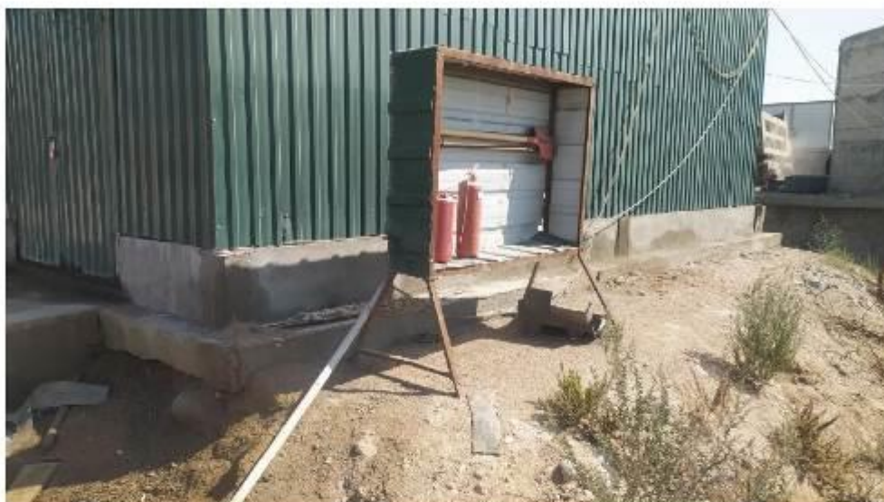
Фото 4. Газовые баллоны до сих пор не прикрыты от прямого попадания солнечных лучей
